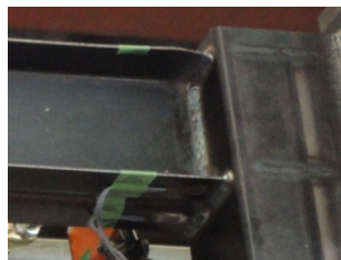
図 5 局部座屈発生部分 (上梁右端部)
