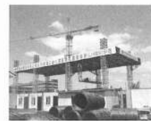
④自動施工システム
