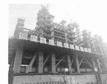
⑤鉄骨造高層住宅
